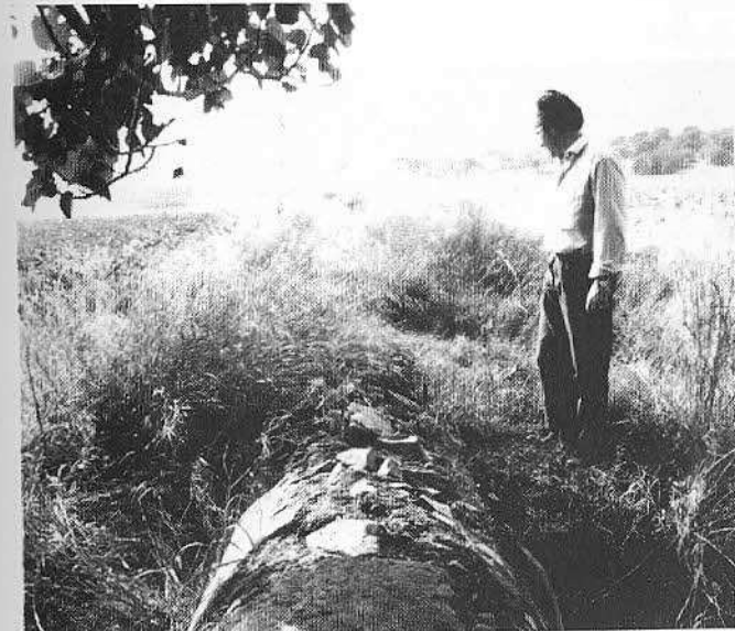
Fig. 53: Restos acueducto en arroyo Nogales, reaprovechados por EMACSA. Tubería moderna en interior.
