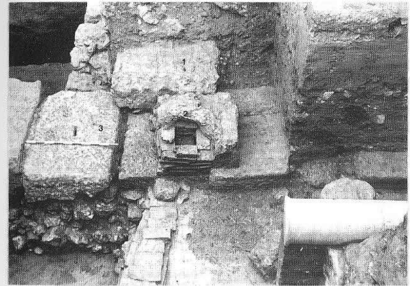
Fig. 2: Excavación en C. Ramírez de Las Casas-Deza: Restos de cimentación fuente: 1, tubería de plomo- 2, sumidero- 3, cubierta de la cloaca.
