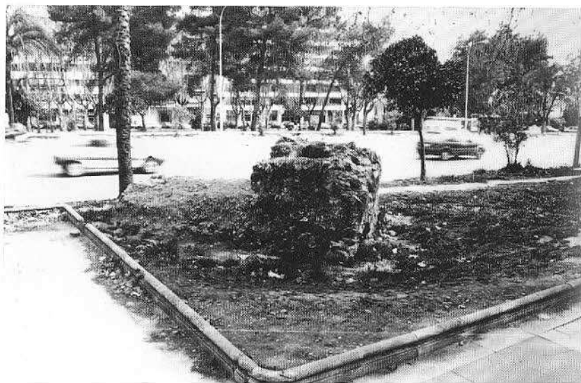
Fig. 56: ¿Depósito terminal de acueducto de Vallehermoso?.
