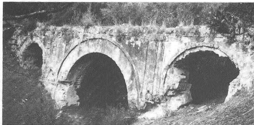
Fig. 21: Puente-acueducto de Valdepuentes.
