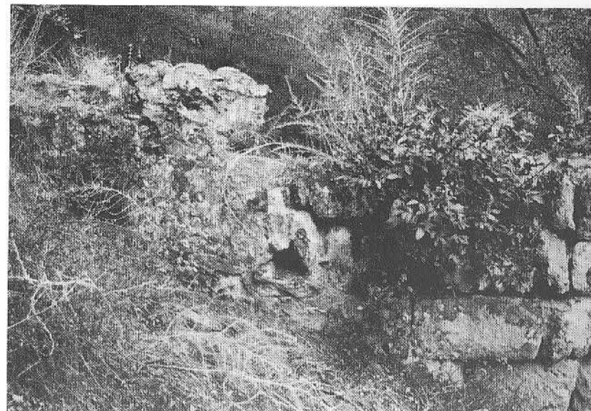
Fig. 23: Puente-acueducto de Valdepuentes. Estribo occidental.
