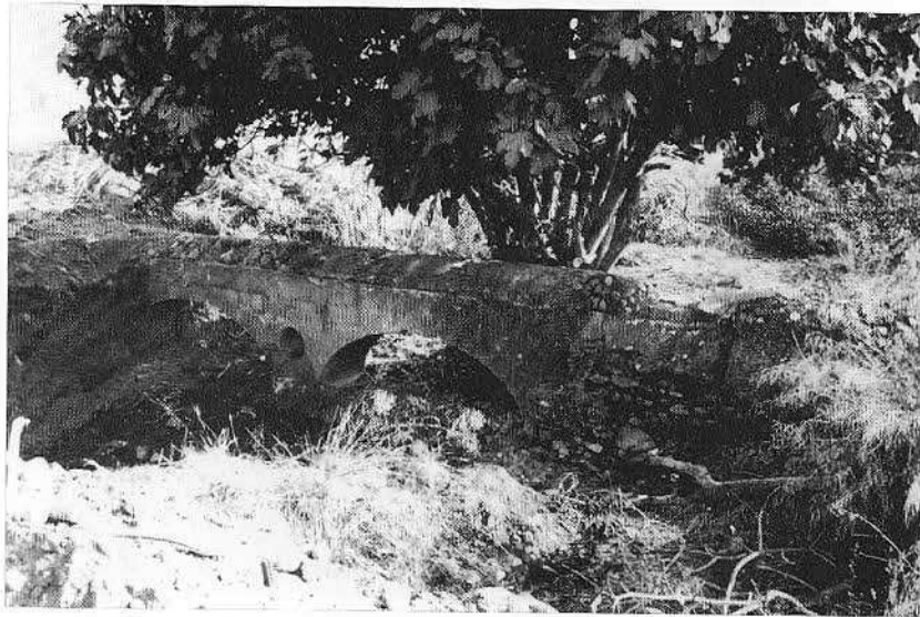
Fig. 54: Puente reconstruido por EMACSA. Estribo antiguo de caementicium del puente original romano.
