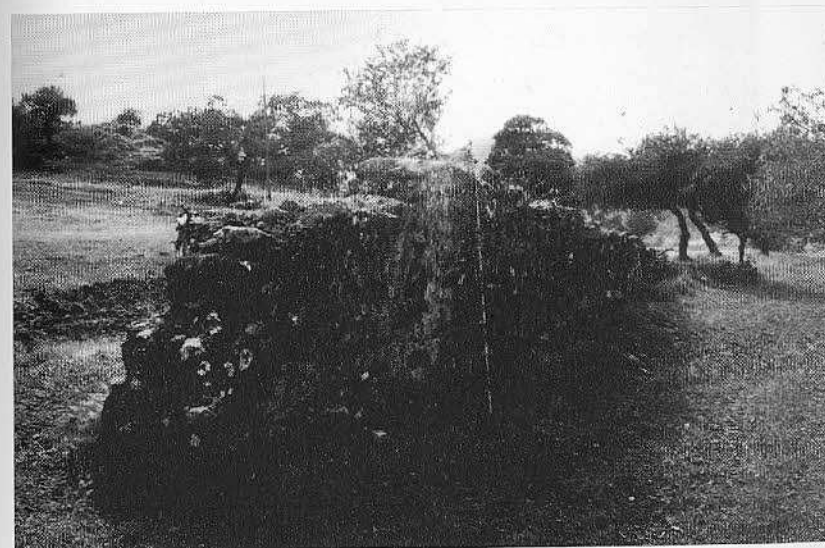
Fig. 49: Murallón substructio acueducto de Vallehermoso junto al camino de Casillas del Aire. (Fig. superior) Fig. 50: Idem.. Vista general.
