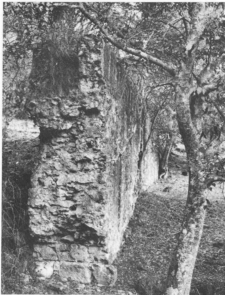
Fig. 27: Puente-acueducto nº 2 romano de la vaguada de Valdepuentes.
