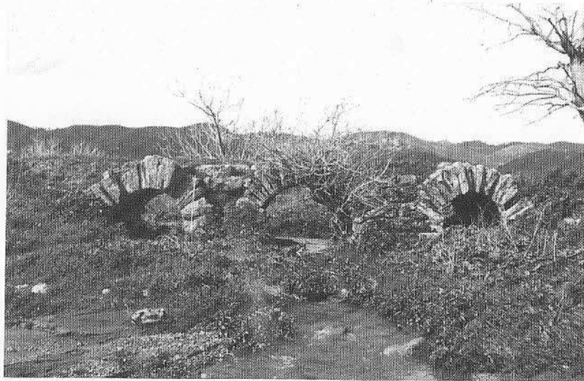
Fig. 37: Puente califal de calzada en arroyo Nogales. Bajo él, subterráneo, discurre el acueducto.
