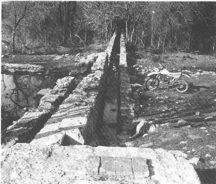
Fig. 15: Vista hacia el Norte, desde alcubilla de la Fuente del Elefante. El agua no puede circular por el canal en esa dirección, al ir contra la pendiente del specus .
