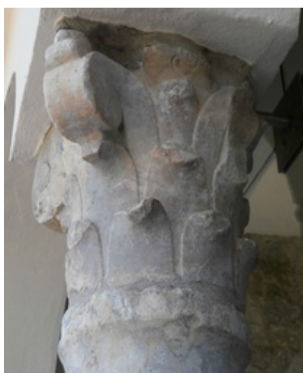
Fig. 57 Capitel de la entrada de la torre
