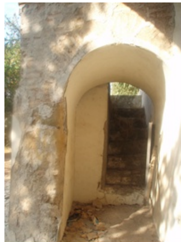
Fig. 29 Escalera de subida a la terraza
