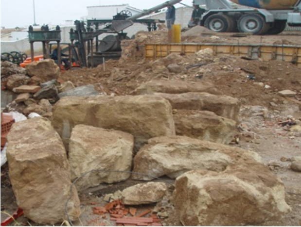
Fig. 77 Restos del molino de aceite y sillares del muro
