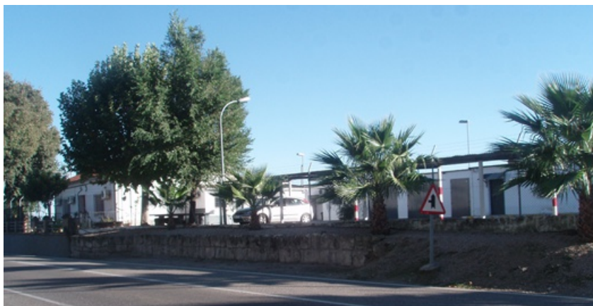
Fig. 58. Sillares en el muro de contención de la planta asfáltica.
