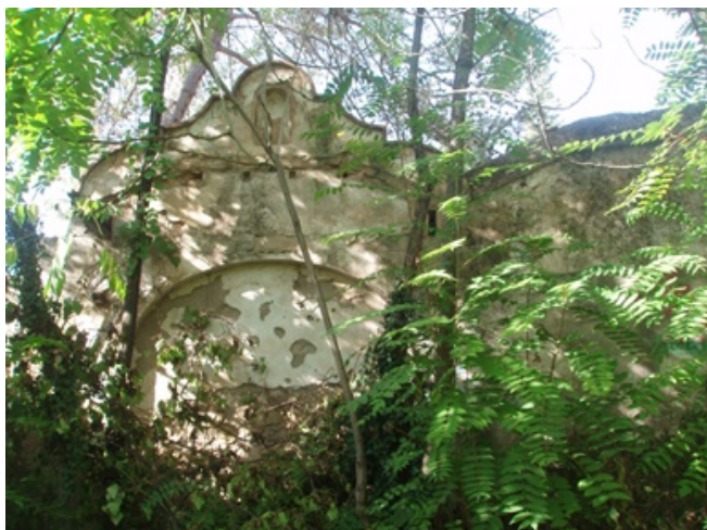
Fig. 31 Muro del convento y rinconada de la puerta antigua del Compás
