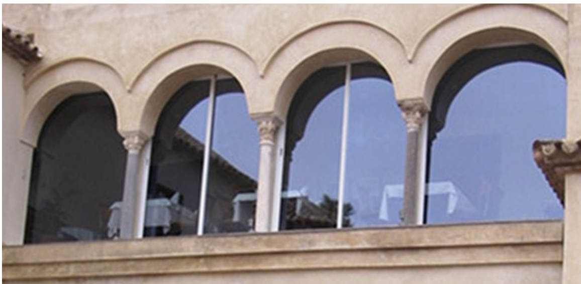
Fig. 51 Fachada de la Albaida con los tres capiteles
