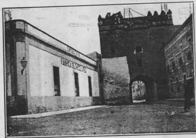
La Puerta Osario (Bab Yehud) vista desde el Campo de la Merced, tal como estaba en 1902, poco antes de ser demolida.
