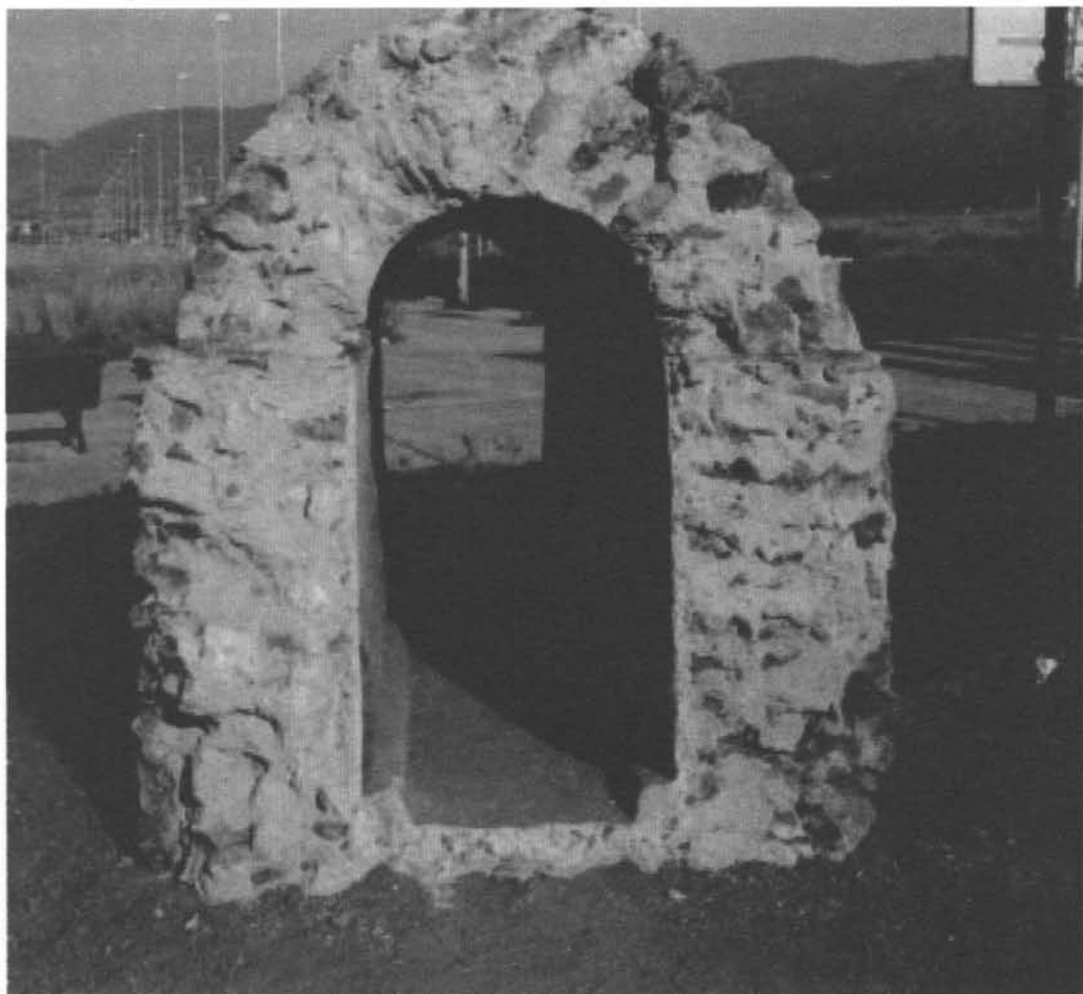
Resto de Acueducto excavado en el Tablero de la Arruzafa procedente de Trassierra que conducía agua a la Almedina.
