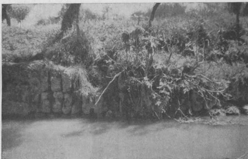
Aparejo de sillares de arranque de puente
