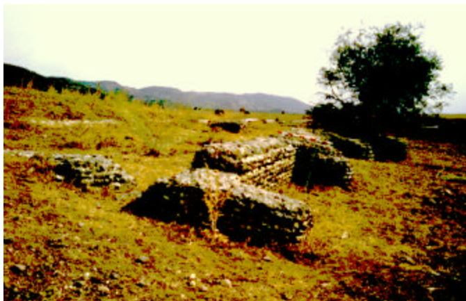
Fig. 145. Cisterna de 28 Córdoba La Vieja con contrafuertes en el flanco de mayor pendiente.
