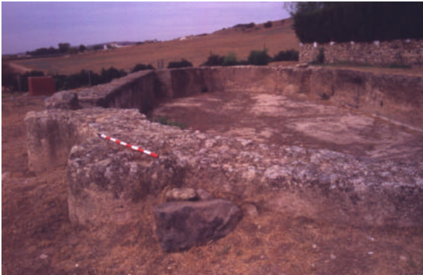
Fig. 146. La gran cisterna de 29 Las Pitás, con contrafuertes semicilíndricos en cada uno de los dos ábsides de remate de sus extremos.
