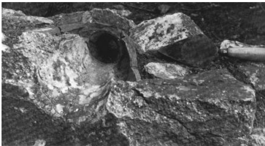
Fig. 148. Cisterna griega de Laurión (Healy, 1978, fig. 43) en la que se observa un cuello de ánfora aplicado para provocar un chorro de lavado a presión, tal y como hemos constatado en la cisterna biabsidial de Las Pitás.
