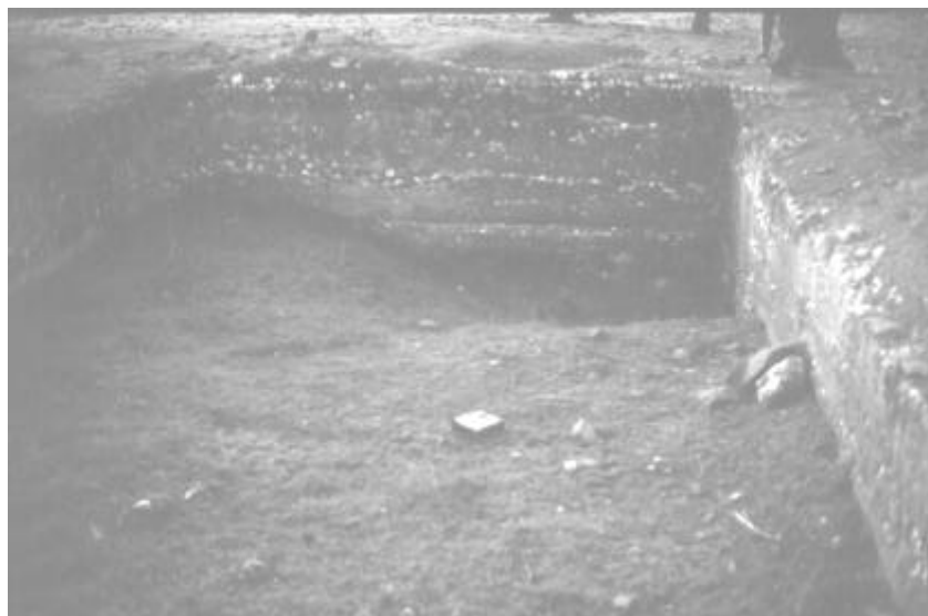
Fig. 149. La mayor de las cisternas de 49 Majadalaiglesia, en la que se observan las sucesivas tongadas de construcción.
