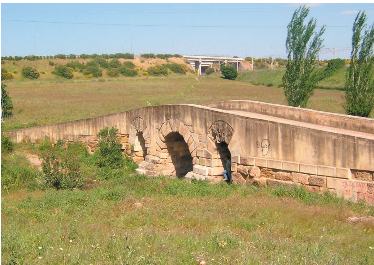
Puente Molino de los Ciegos sobre el arroyo Pedroche.
