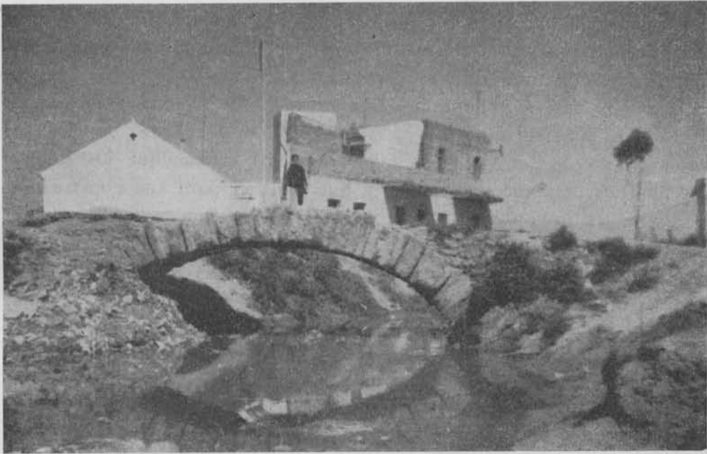
Puente del camino de Burriçiegos por un costado
