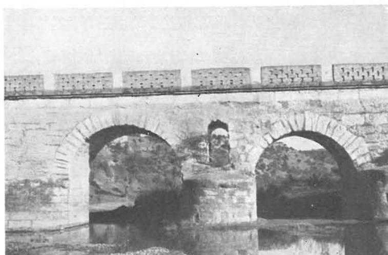
Puente de diez vanos, con luces comprendidas entre 4,50 m y 6,60, separados por pilas oscilando entre 3 y 4,20 metros. En una longitud total de unos 100 m tenemos un desagüe lineal de 55 m, lo que da una relación media de macizo a vano de 0,84.
