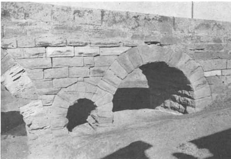
De un lado se apoyan sobre el arranque de la bóveda principal intercalando una superposición de sillares de forma diferente, que constituye su pilastra independiente. La otra pilastra resulta casi simétrica, de tal modo que el arquillo con sus dos pilastras se destaca claramente, a costa de dejar en un forzado equilibrio a los dos arcos laterales, cuyo medio punto altera como acabamos de indicar. Todas las bóvedas de arcos y arquillos arrancan del mismo plano horizontal.
