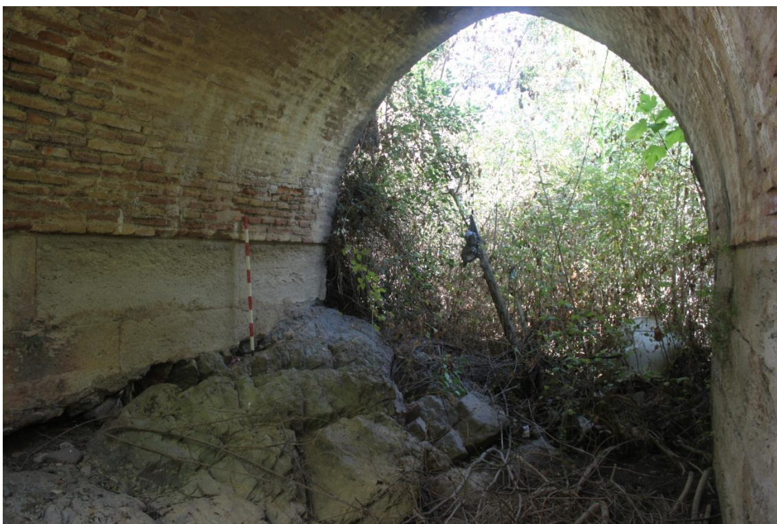
Fig. 25. Estribo oriental, que se apoya directamente sobre la roca madre.
