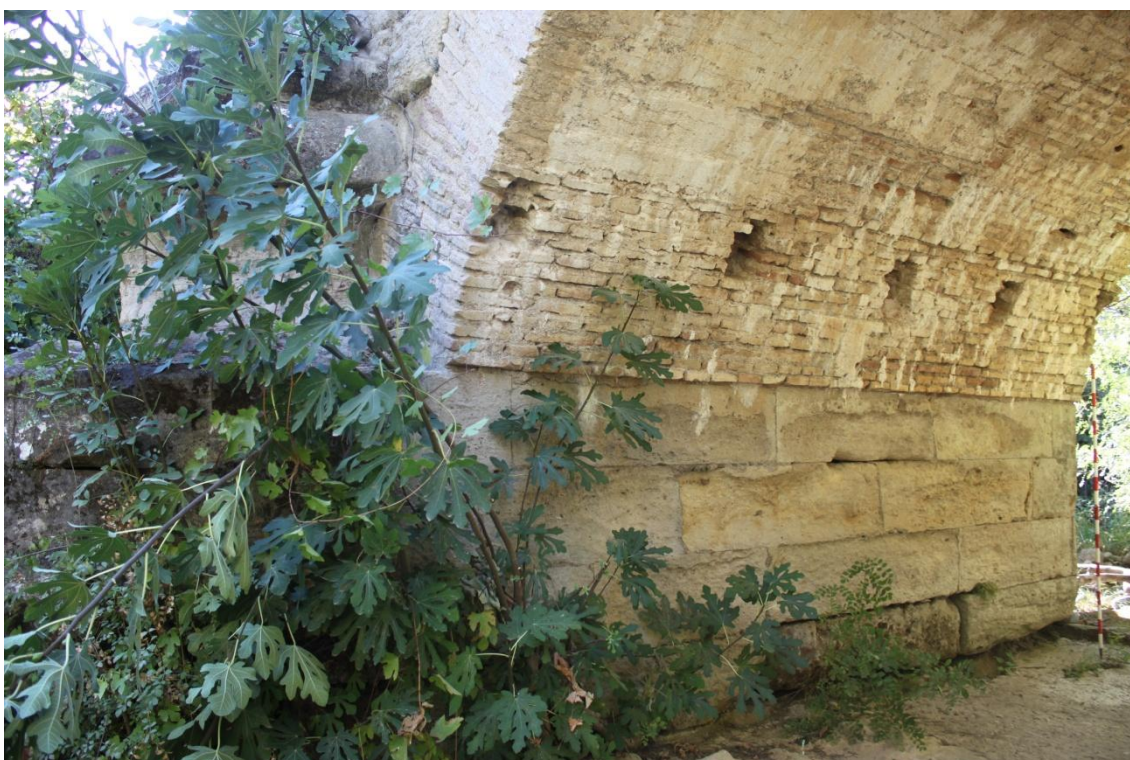
Fig. 7. Línea de mechinales sobre el pilar occidental del arco central.
