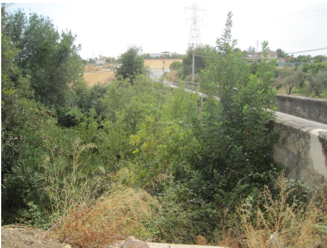
Fig. 37. Vegetación aguas abajo del puente (a la derecha de la imagen).
