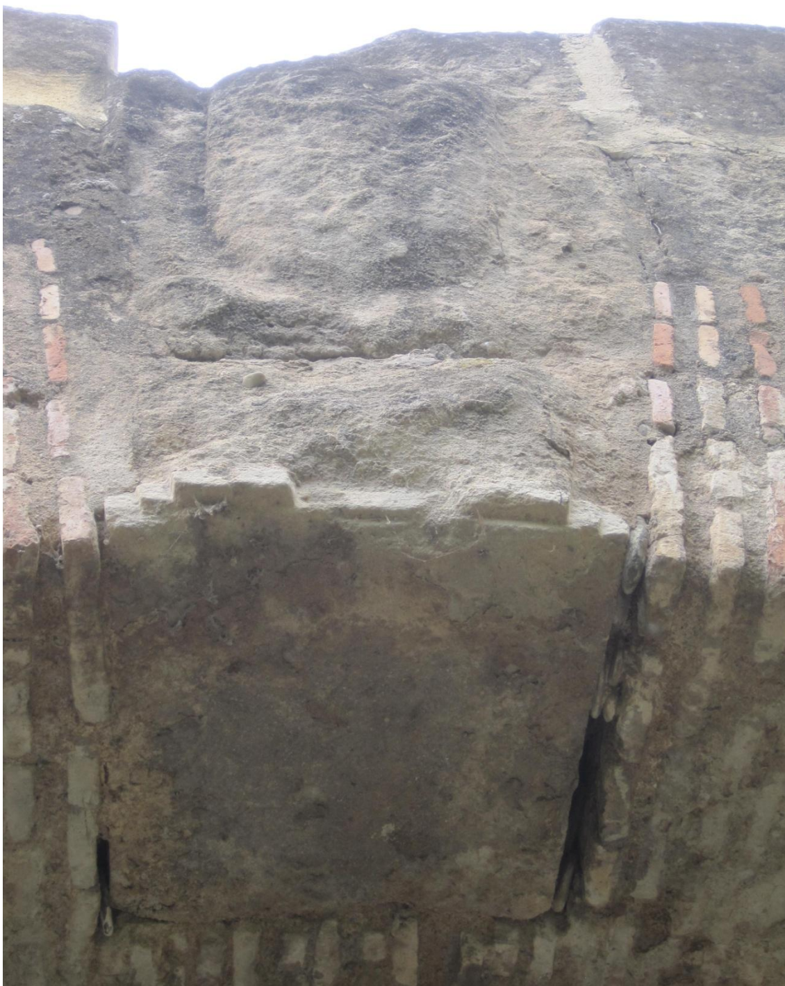
Fig. 10. Detalle del escudo situado sobre la rosca del arco central (aguas abajo).
