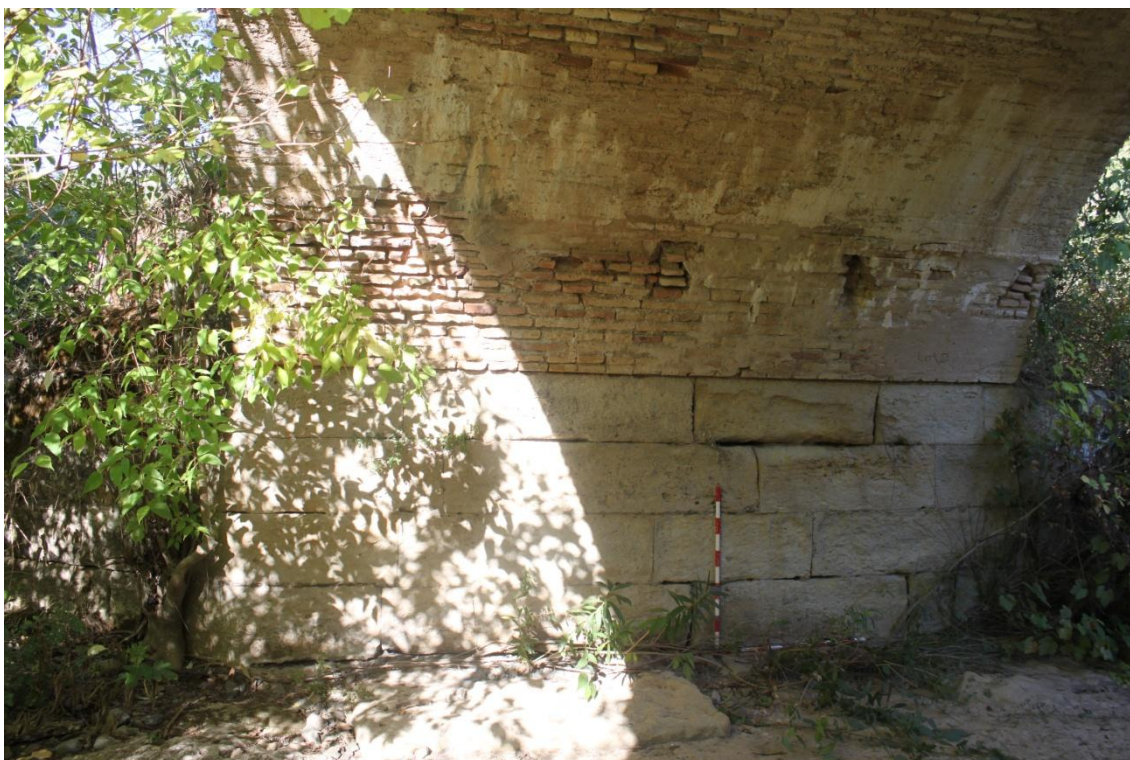
Fig. 8. Línea de mechinales sobre el pilar oriental del arco central.
