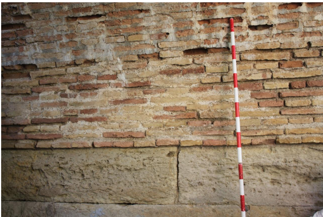
Fig. 12. Mortero empleado a la hora de unir los ladrillos.
