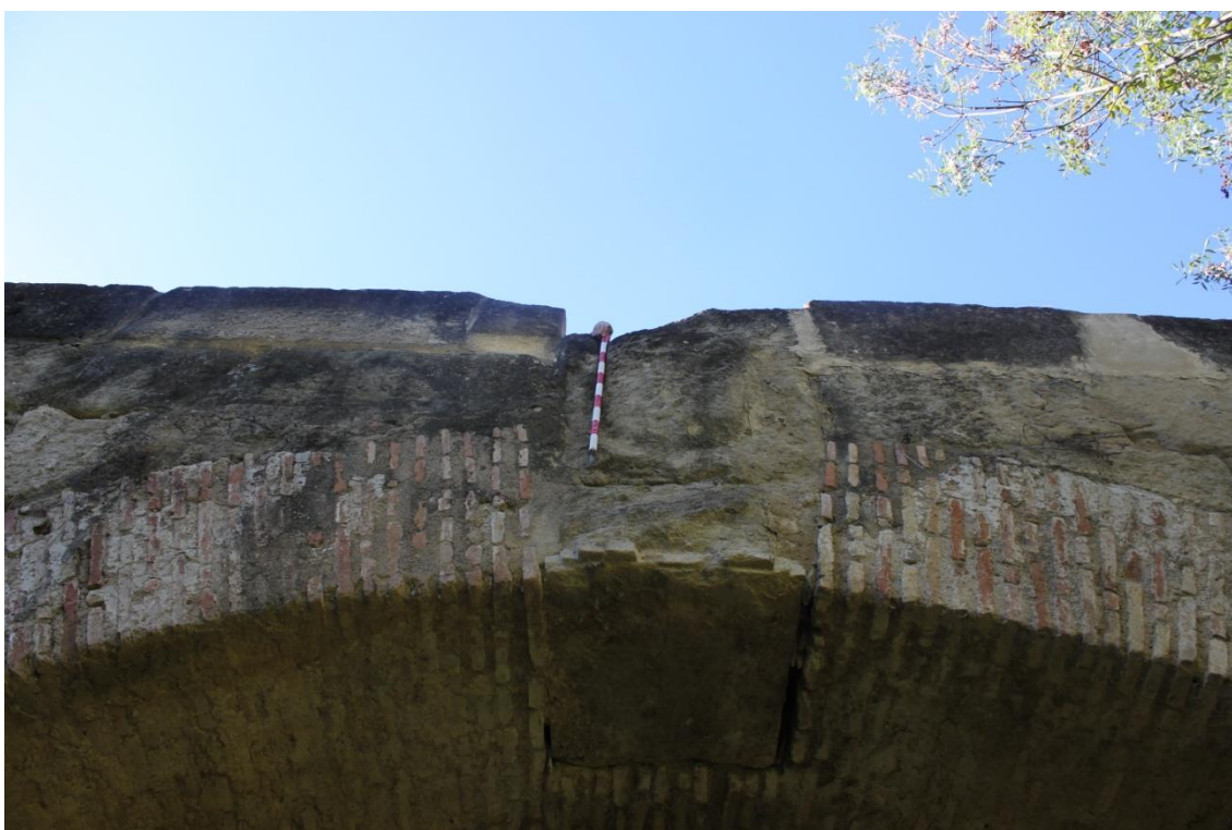
Fig. 9. Escudo situado sobre la rosca del arco central (aguas abajo).
