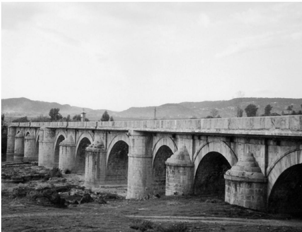
Fig. 28. Puente de Alcolea. Detalle de los sombreretes en los tajamares (RUBIATO, 2002, fig. 12).
