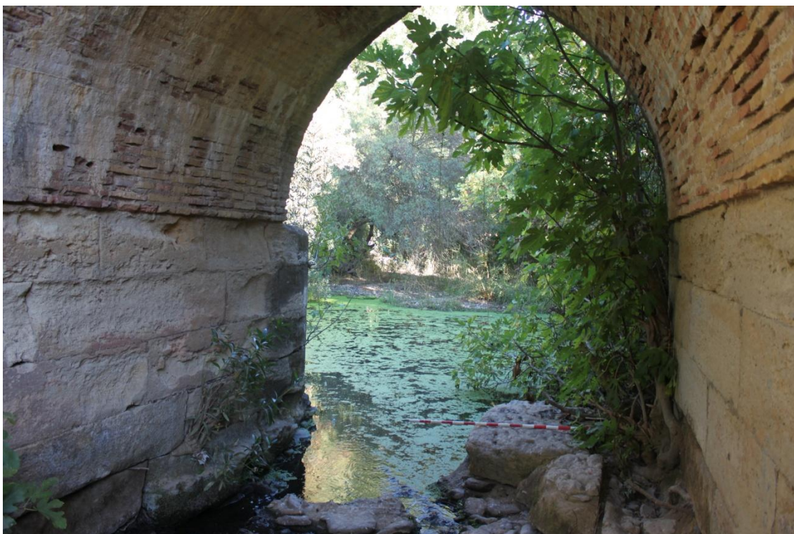
Fig.5. Arco occidental (aguas abajo).
