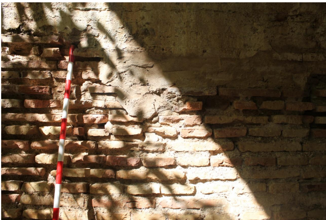
Fig. 14. Ejemplo de parche contemporáneo de cemento.
