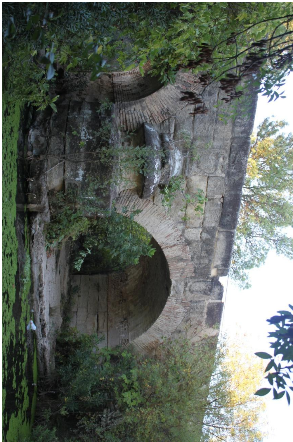
Fig. 1. Arco central aguas abajo
