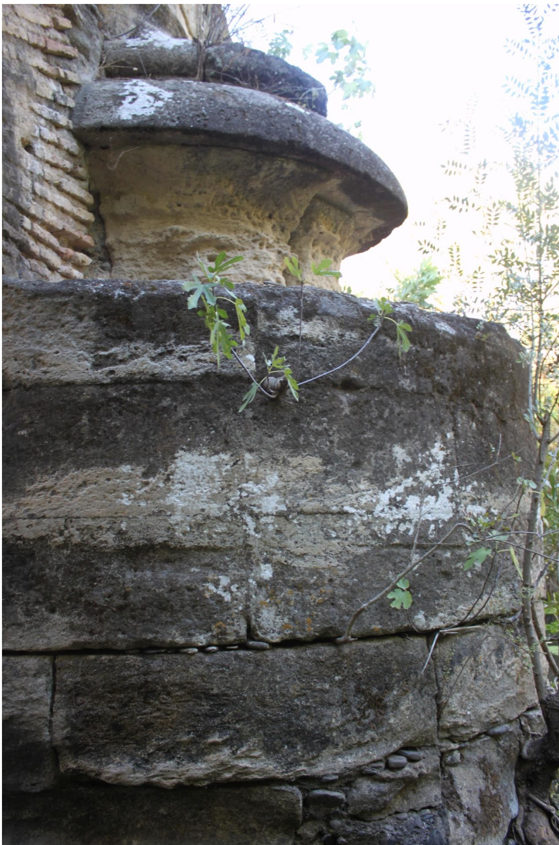
Fig. 18. Tajamar occidental (aguas abajo) y remate.
