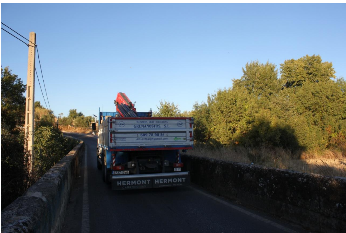
Fig. 35. Vehículo pesado cruzando el puente romano sobre el arroyo Guadalbarbo.
