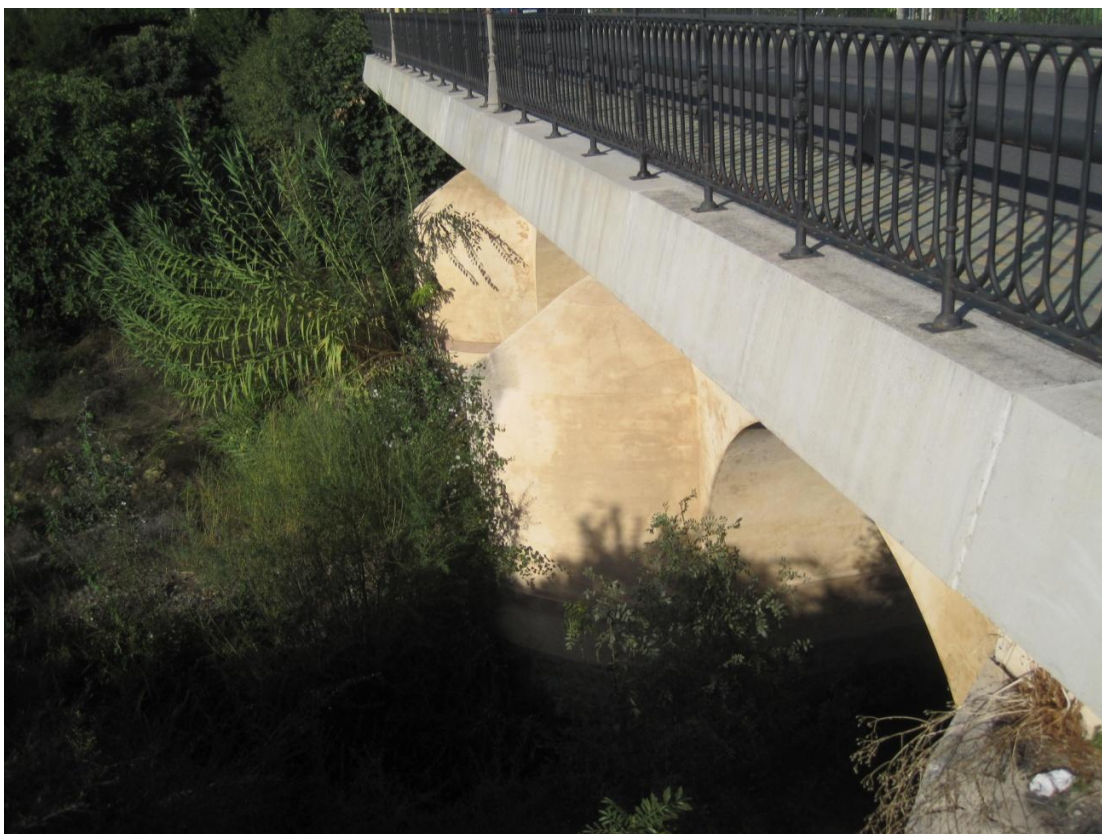
Fig. 34. Vista actual del puente que forma parte de la N-IV (situado menos de 700 metros al sur del puente objeto de la catalogación)
