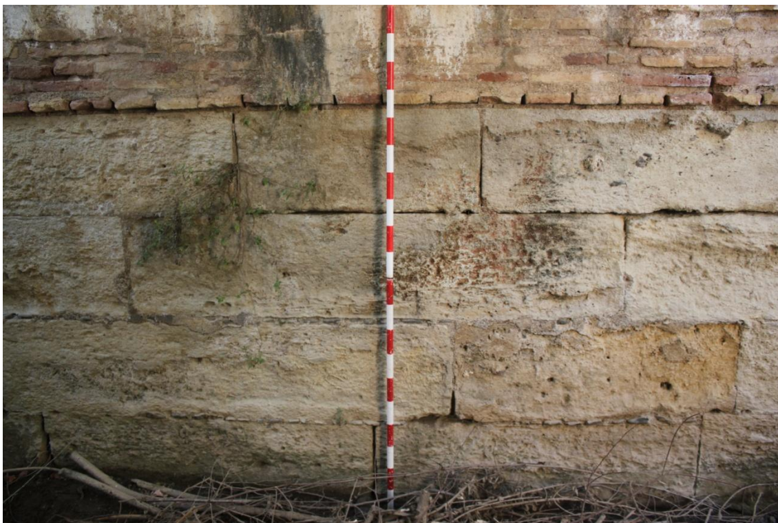
Fig. 22. Argamasa y cantos rodados que traban los sillares.
