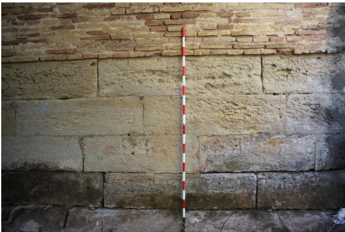
Fig. 20. Sillería empleada (estribo occidental).
