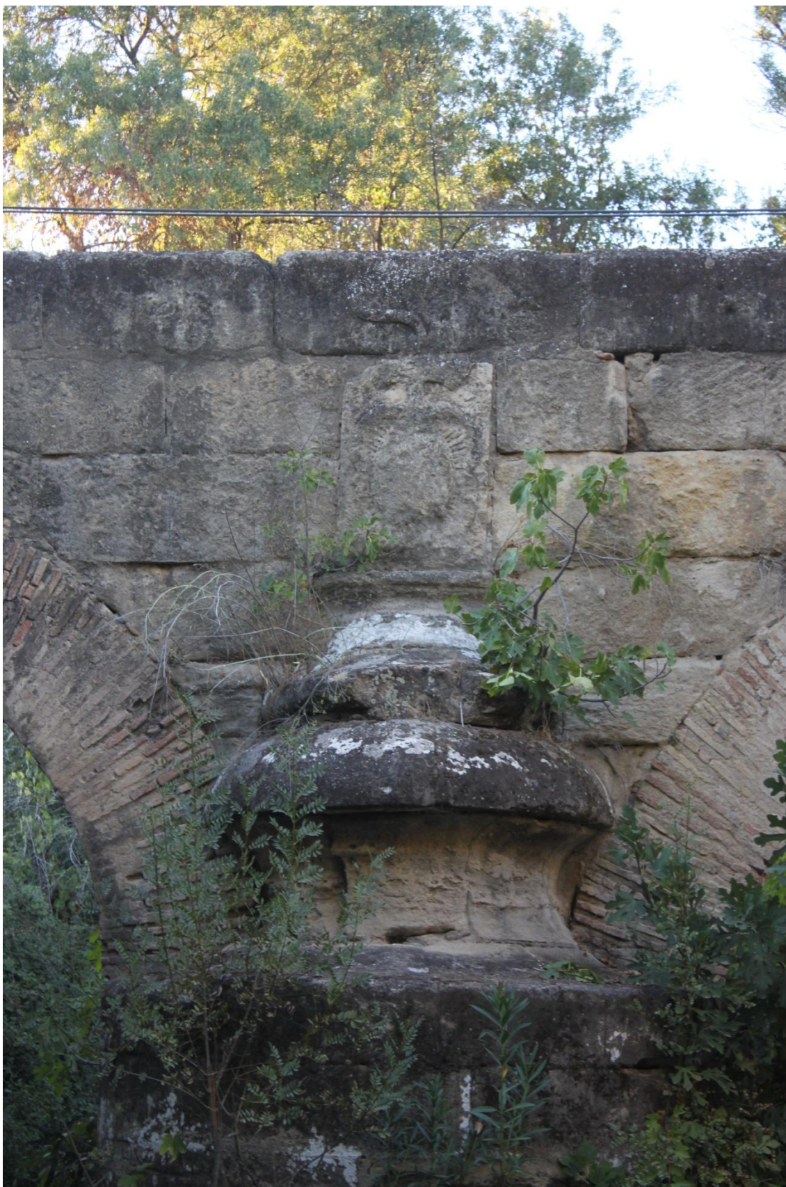
Fig. 17. Tajamar occidental (aguas abajo).
