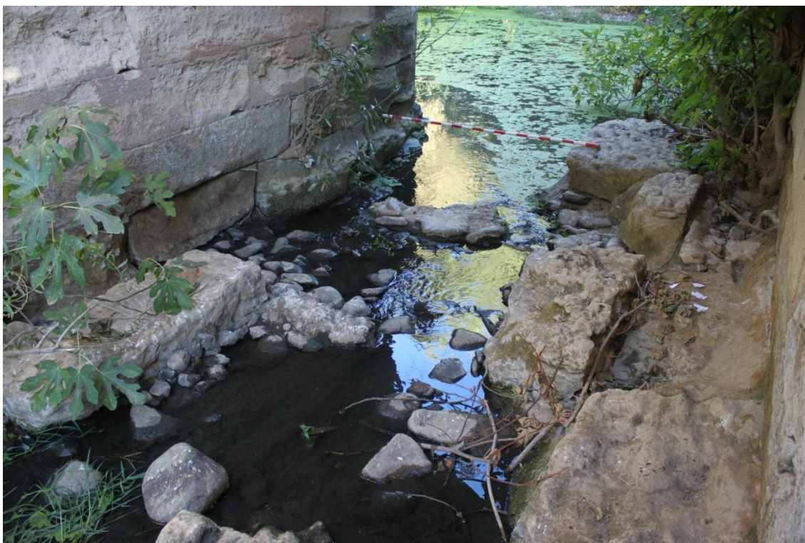
Fig. 23. Zampeado (y su cama) a su paso por el vano occidental
