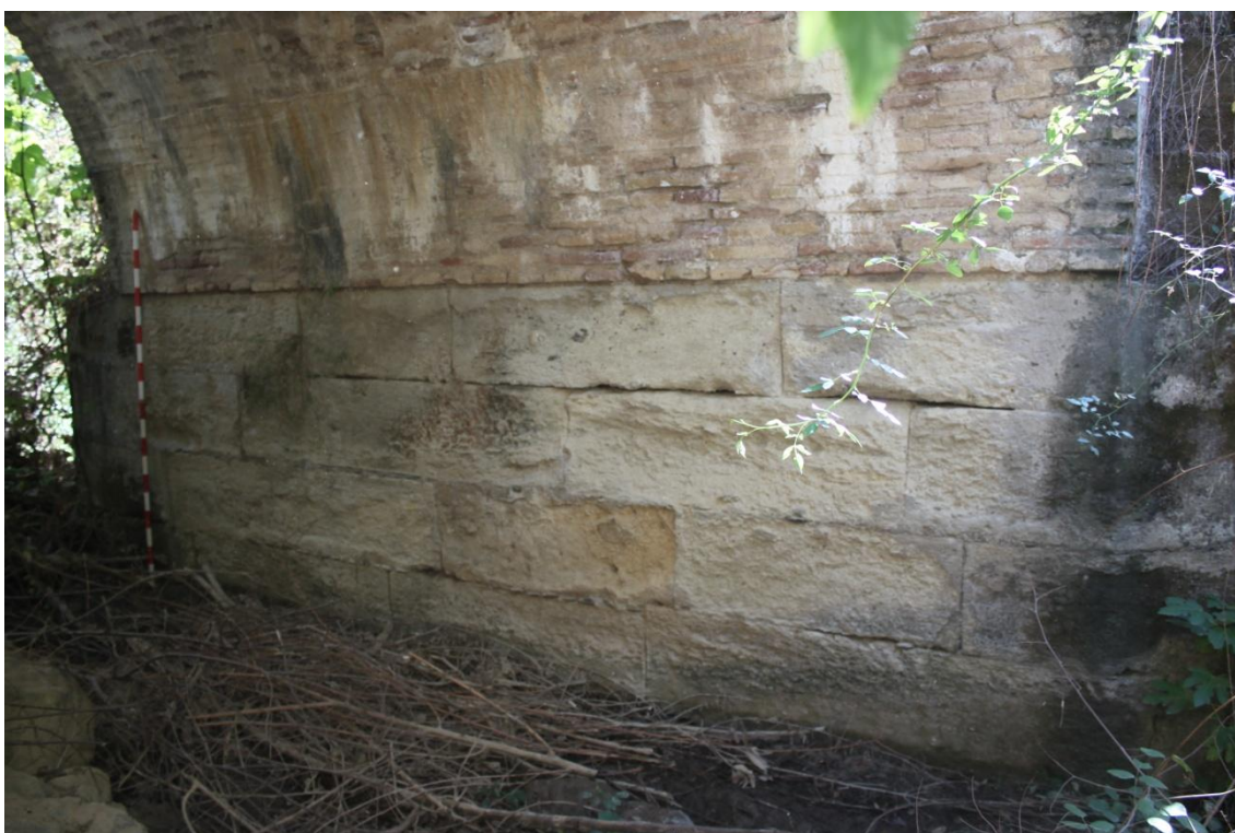
Fig. 21. Sillería empleada (pilar oriental).
