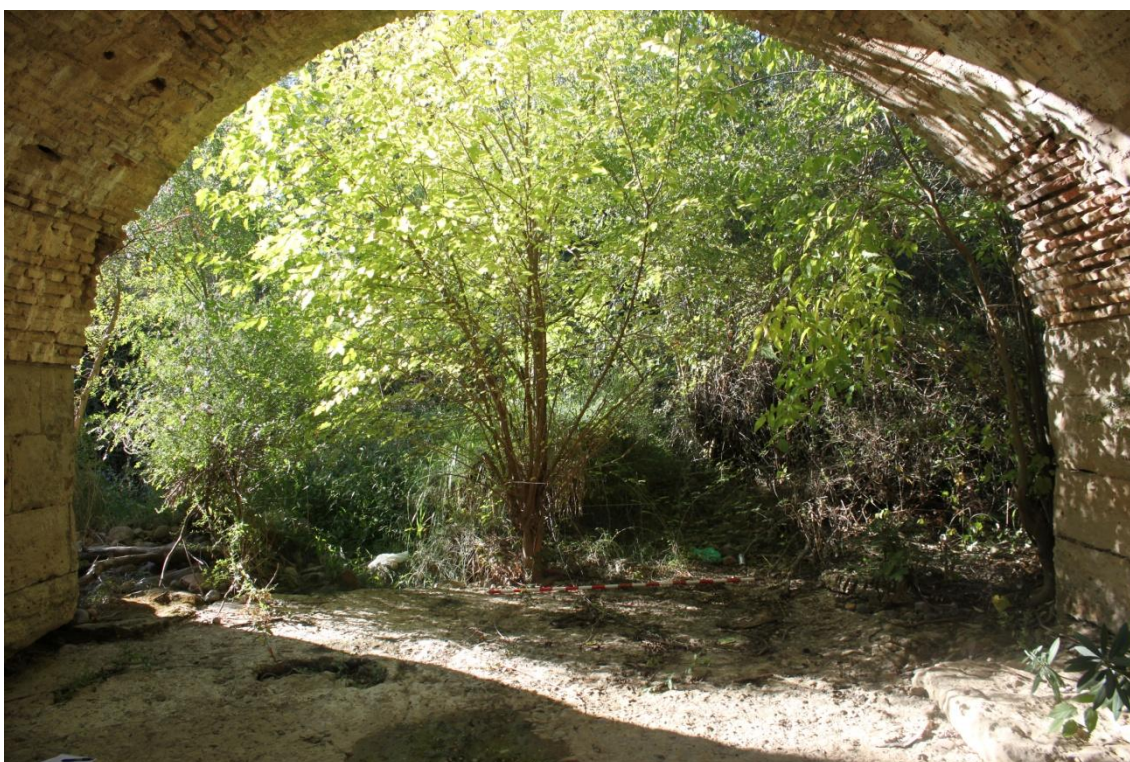
Fig. 3. Arco central (aguas arriba).
