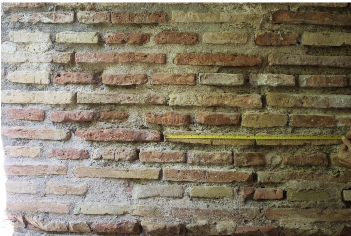
Fig. 6. Tamaño de algunos de los ladrillos empleados en la fábrica de los arcos.
