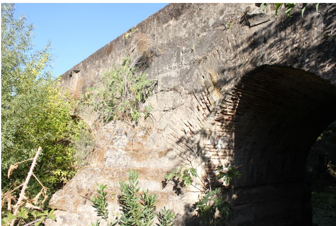
Fig. 16. Remate del tajamar occidental (aguas arriba).
