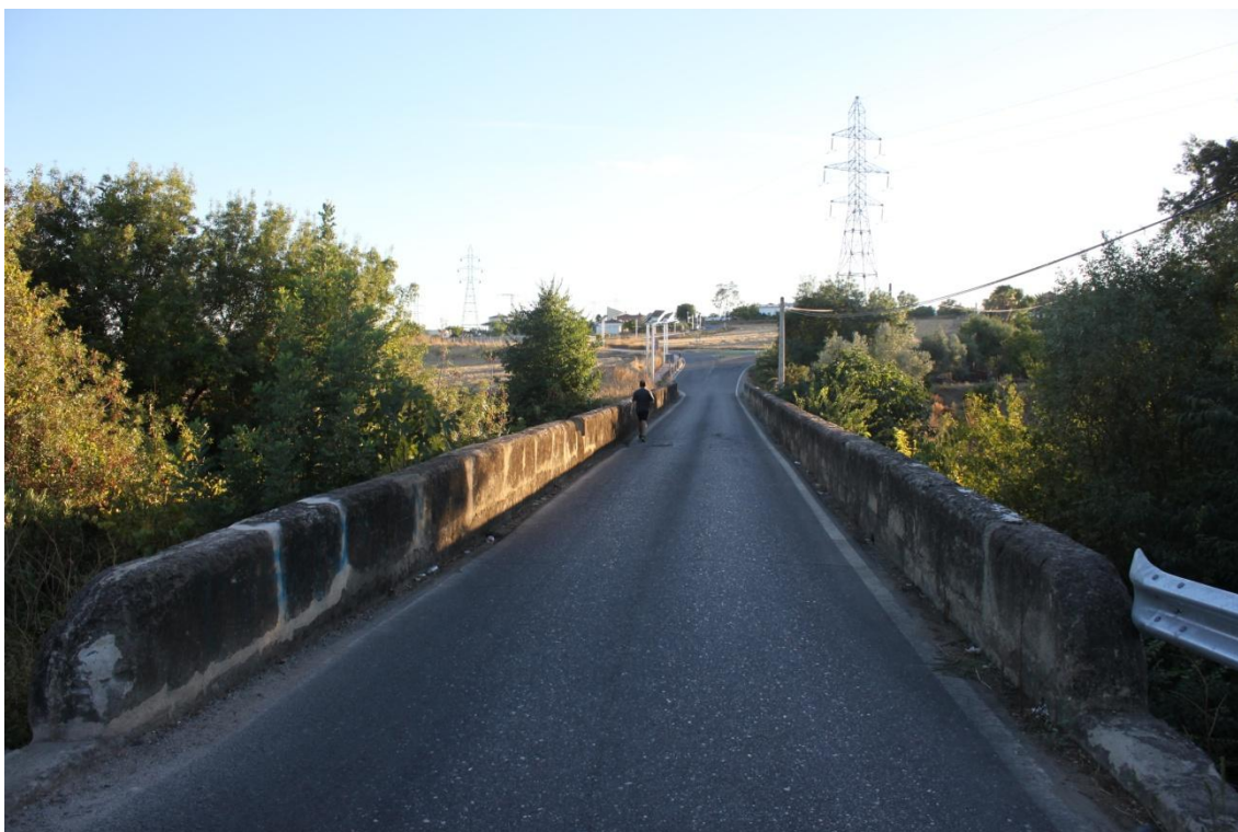
Fig. 26. Tablero del puente
