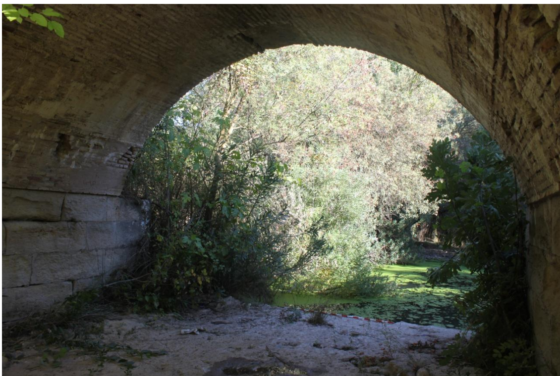
Fig. 2. Arco central (aguas abajo).
