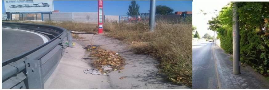
Ilustración 5: A la izquierda falta acera y una “pértiga” para saltar la valla y coger el autobús. A la derecha, calle estrecha que incumple todos los criterios: tiene dos direcciones de tráfico incluyendo autobuses, sus aceras no son practicables en ambos lados y además son altas por lo que es imposible salir de ellas momentáneamente para superar el obstáculo con una silla de ruedas o un cochecito de niño, se volcarían.
