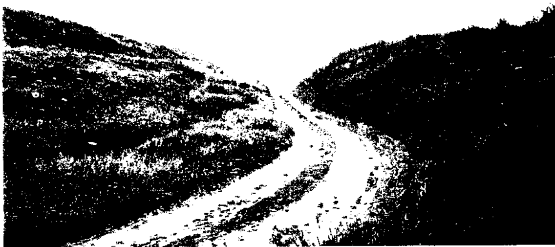
Fig. 8.- Encajonamiento del camino con el fin de aminorar la pendiente existente (sector 3.º)
