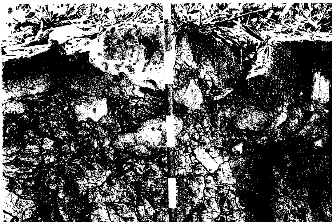
Fig. 2.- Estructura interna del camino (sector 1.º).
